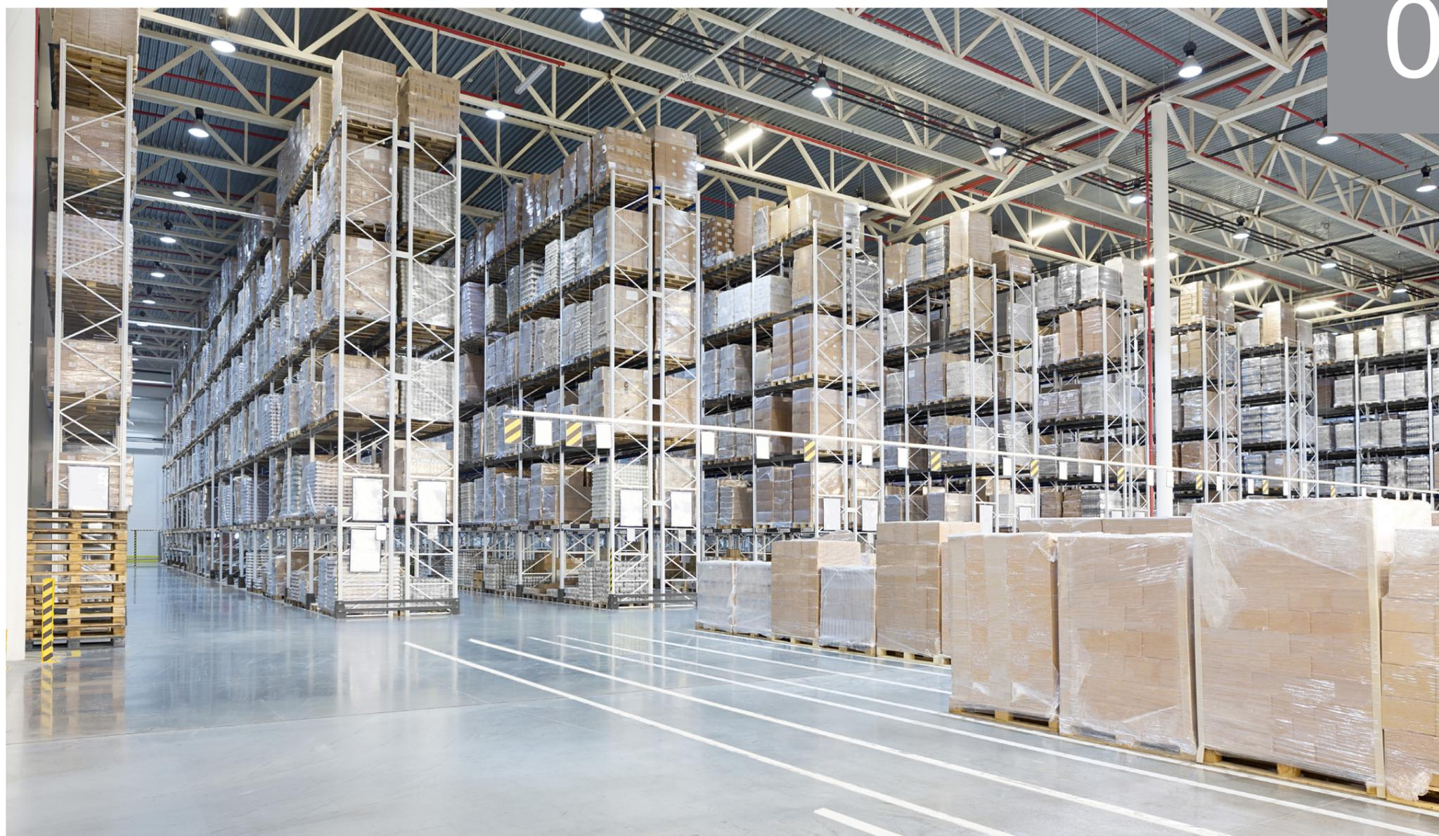
现代化高效率的仓库, 陈列货架分类清晰, 配以机械化、自动化存取作业设备, 储存能力和工作效率都可得到有效的提高。照明灯具和照明方式的选择, 应考虑能够为快速准确存取货架上的货物提供足够的照度, 尤其是货架面上的垂直照度。一般而言, 在灯具排布上建议与货架陈列方向一致, 可保证货架间的通道照度充足的同时也可保证货架上有足够的垂直照度。
