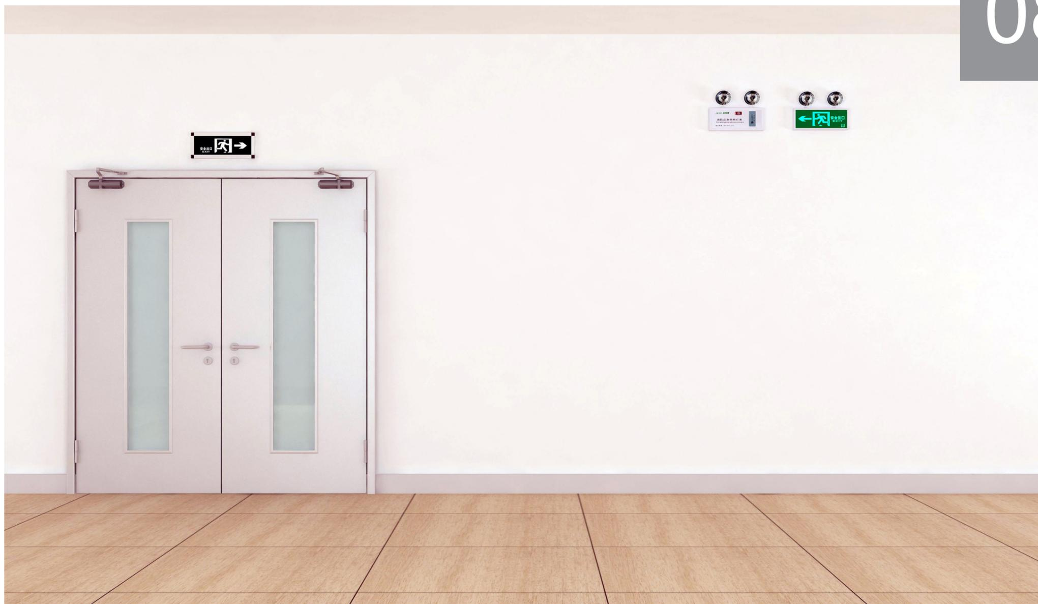
因正常照明的电源失效而启用的照明称为应急照明。应急照明不同于普通照明,它包括:备用照明、疏散照明、安全照明三种。转换时间根据实际工程及有关规范规定确定。应急照明是现代公共建筑及工业建筑的重要安全设施,它同人身安全和建筑物安全紧密相关。当建筑物发生火灾或其它灾难,电源中断时,应急照明对人员疏散、消防救援工作,对重要的生产、工作的继续运行或必要的操作处置,都有重要的作用。
